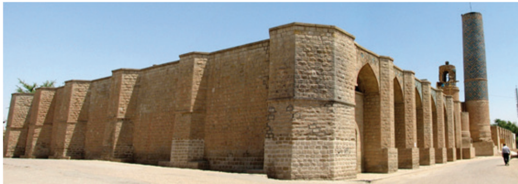
ت ۹. پشت‌بندهای به‌کاررفته جهت جلوگیری از رانش ستون‌های داخلی مسجدجامع شوشتر. مأخذ: نگارنده.
